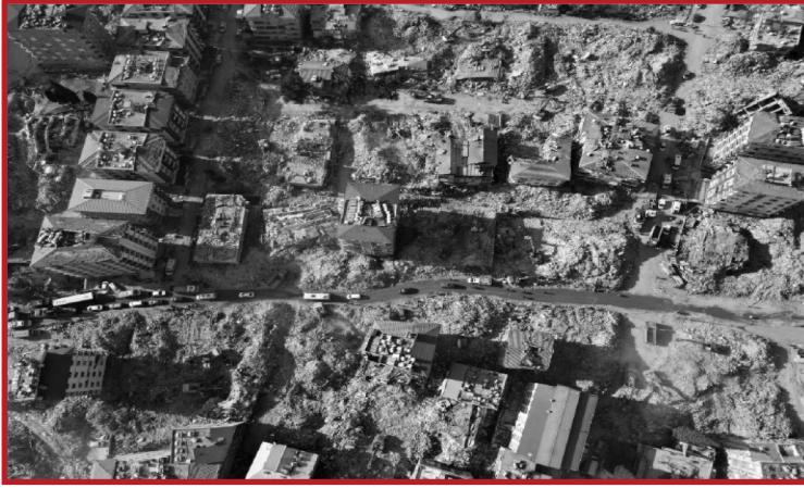
صورة تظهر حجم الدمار في المباني نتيجة الزلزال/ وكالة الاناضول
