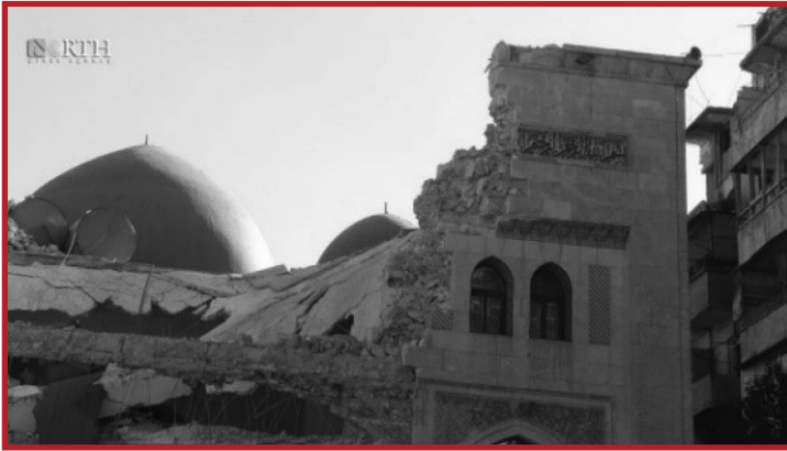
صور أضرار ألحقها الزلزال ببعض المساجد في ريف إدلب / وكالات
