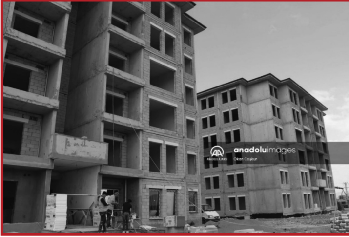
صورة لتشييد المباني الجديدة في مدينة "الإصلاحية" بقضاء "غازي عنتاب" / وكالة الاناضول
